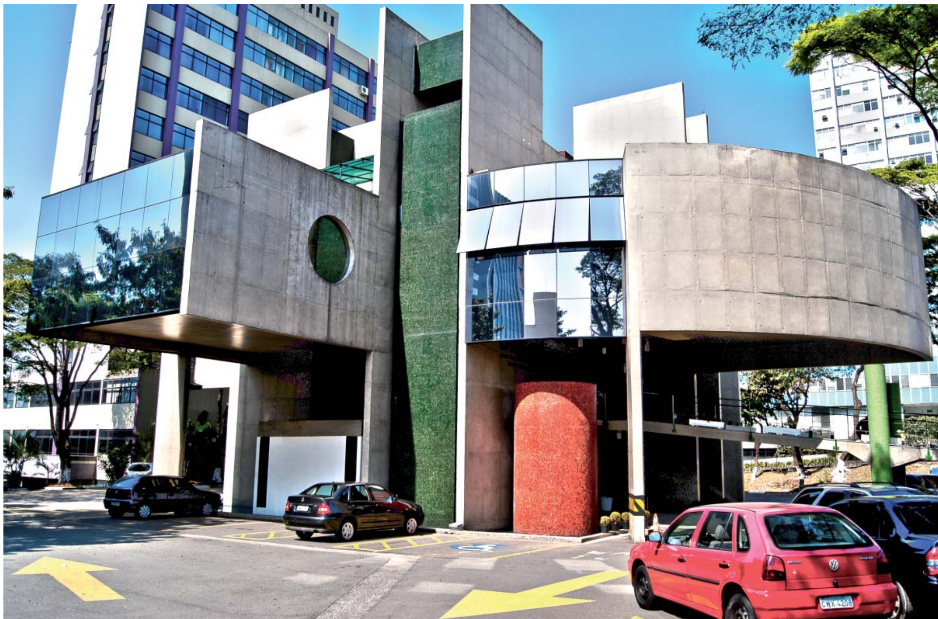
Sede da OAB de Santo André (1992): observar a presença de seções circulares, cortinas de vidro reflexivo e revestimentos cerâmicos em tons variados, semelhantes aos existentes nos edifícios residenciais projetados por Jorge Bomfim a partir da década de 1990 . (BOSCARDIN, L. 2010)
