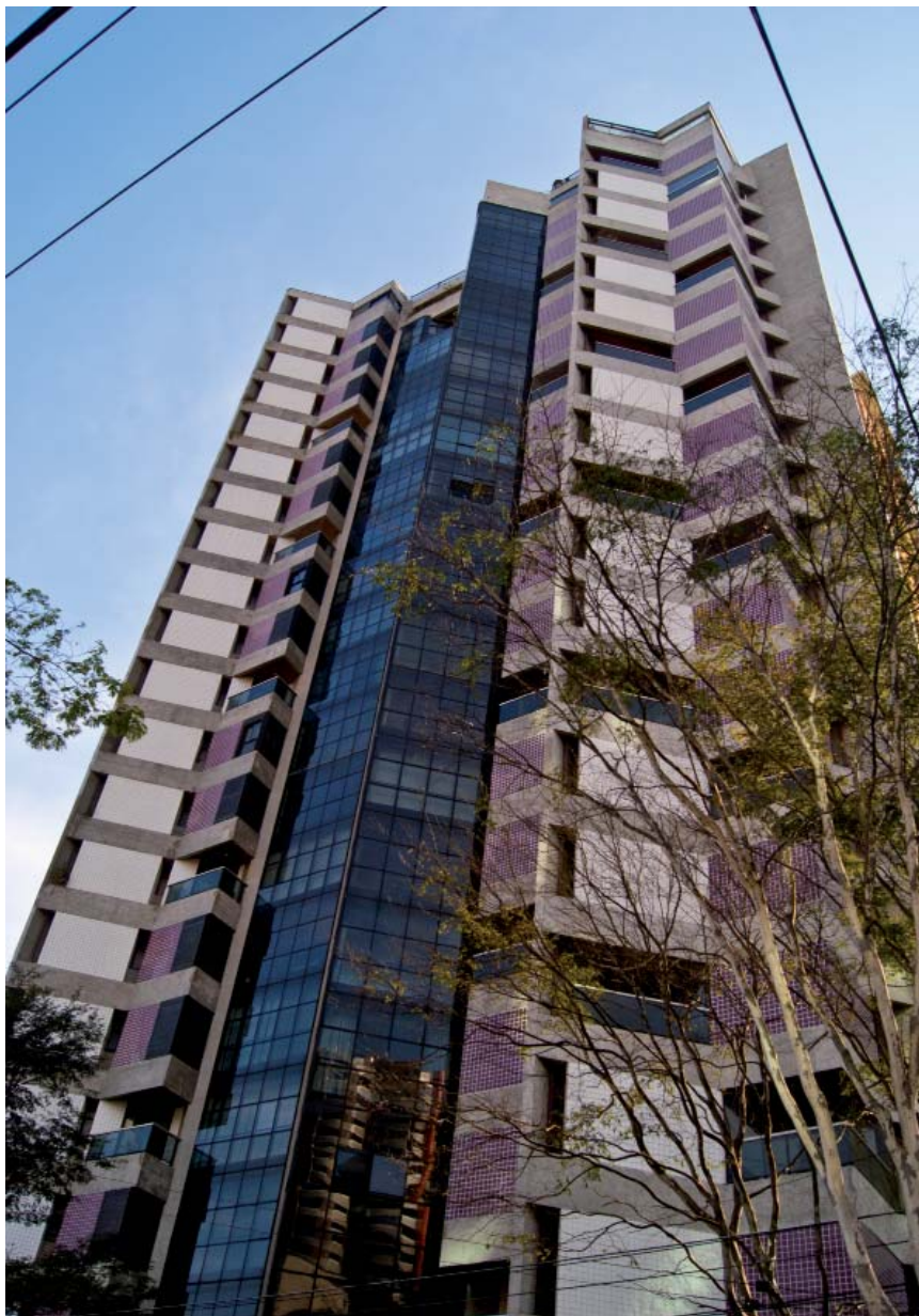
Edifício Octogono: aspecto atual. (BOSCARDIN, L. 2011)
