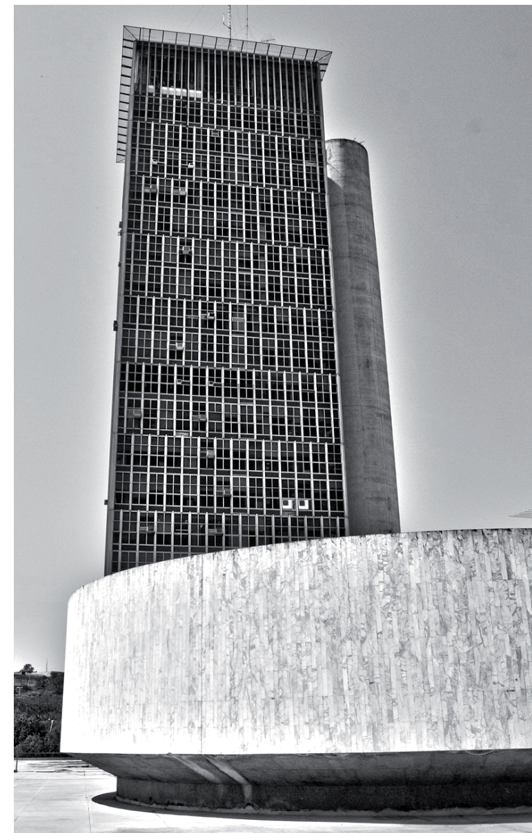
Paço Municipal de São Bernardo do Campo: vista da torre administrativa e câmara dos vereadores. (BOSCARDIN, L. 2010)
