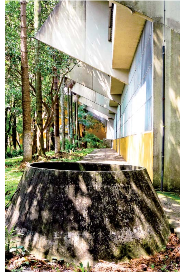
FAECO, destacando cisterna de captação de água pluvial e alteração realizada na década de 1980, com a adição de salas de aula no pavimento térreo. (BOSCARDIN, L. 2012)
