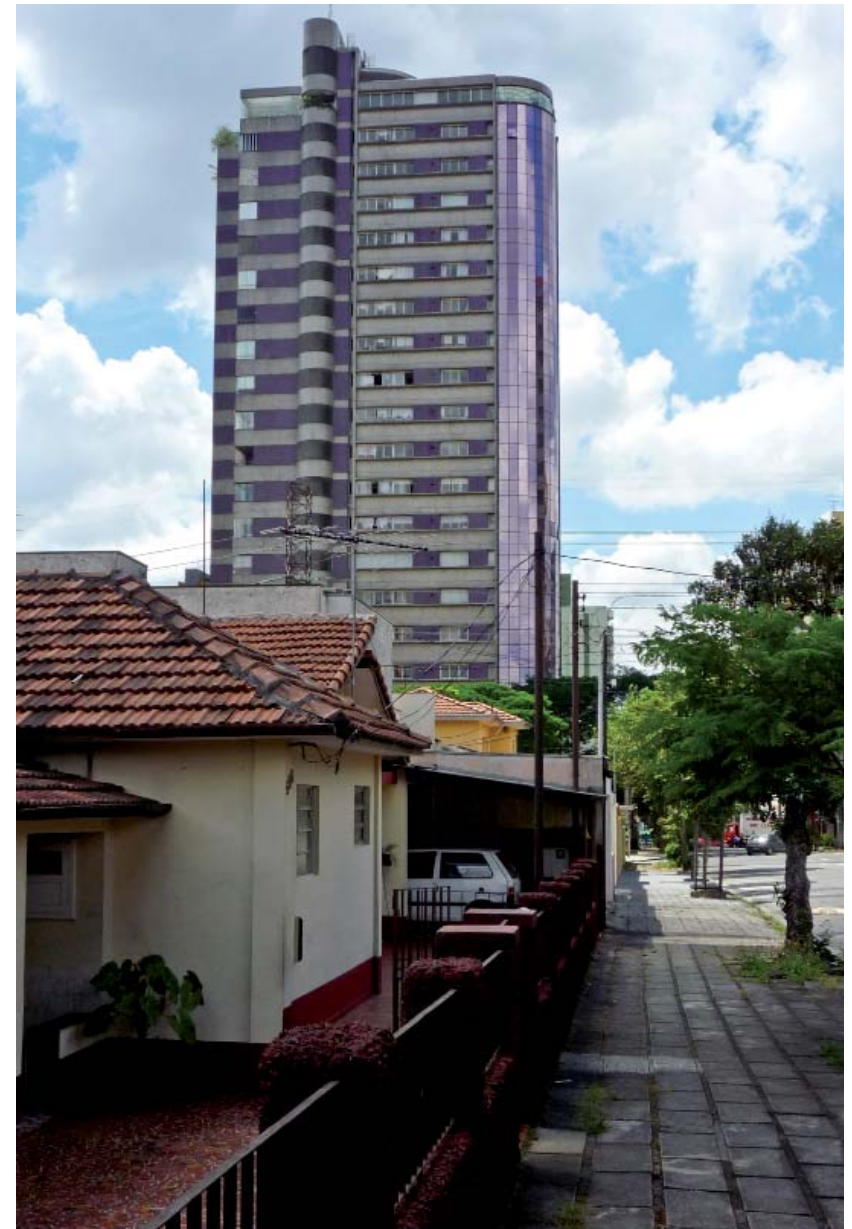
Edifício Gropius (BOSCARDIN, L. 2010)
