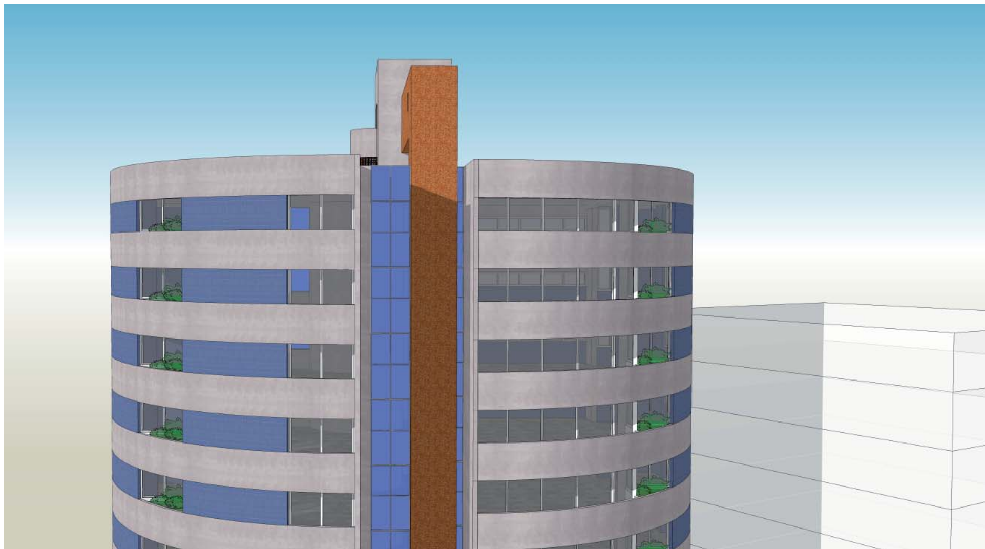
Edifício Gaudí: vista da face norte, destacando a alternância de vigas de concreto aparente e fechamentos revestidos com pastilhas cerâmicas, semelhante à solução utilizada no edifício Gropius. (BOSCARDIN, L. 2012)
