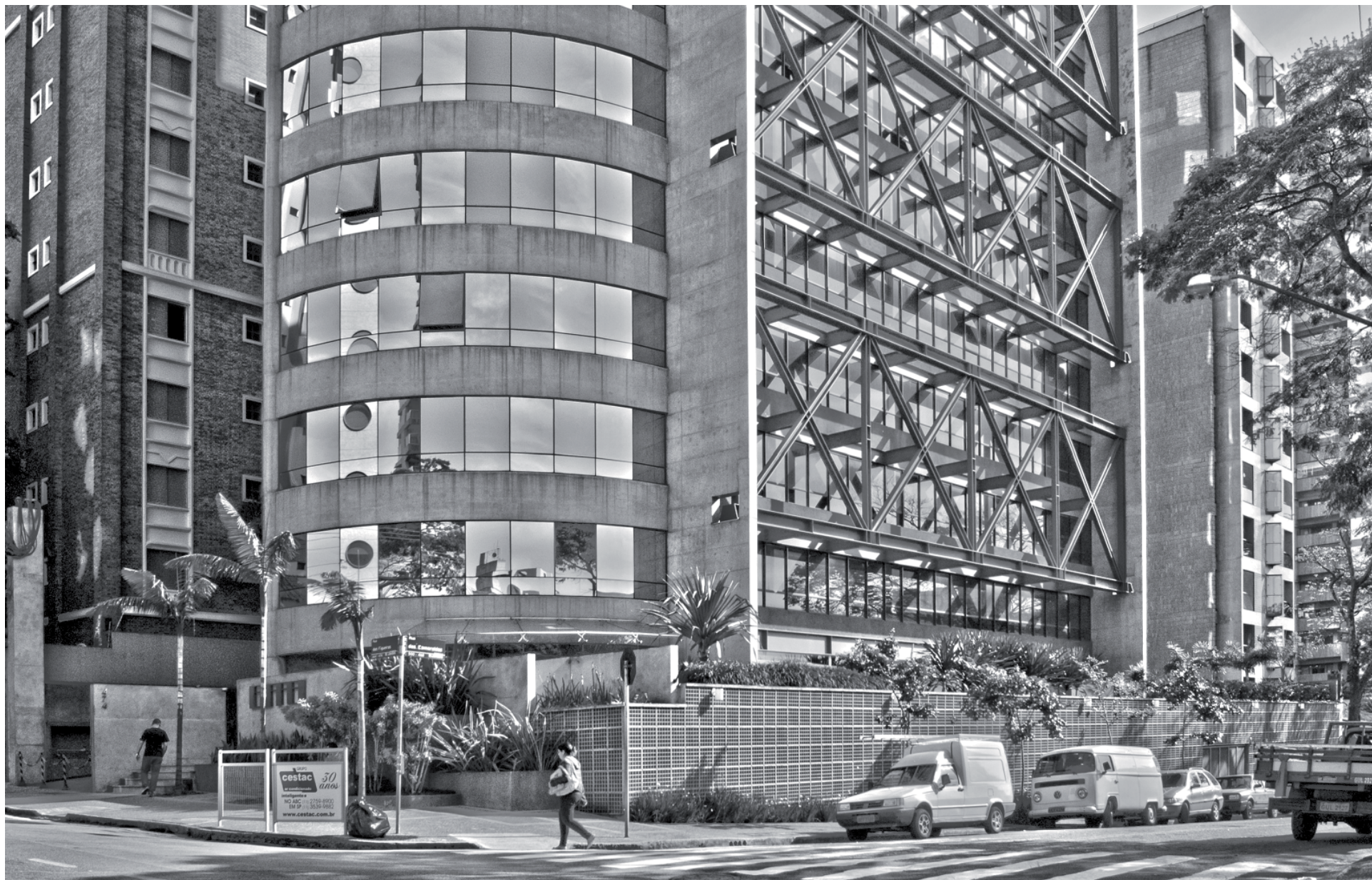
Edifício Eiffel, Santo André. (BOSCARDIN, L. 2011)
