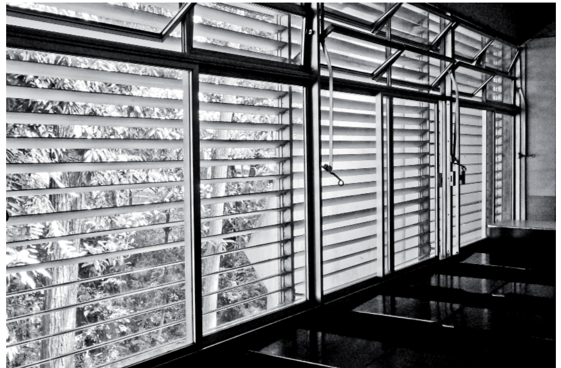
Edifício FAECO, em seu estado atual, destacando a preservada caixilharia e brises metálicos das salas de aula do pavimento superior. (BOSCARDIN, L. 2012)
