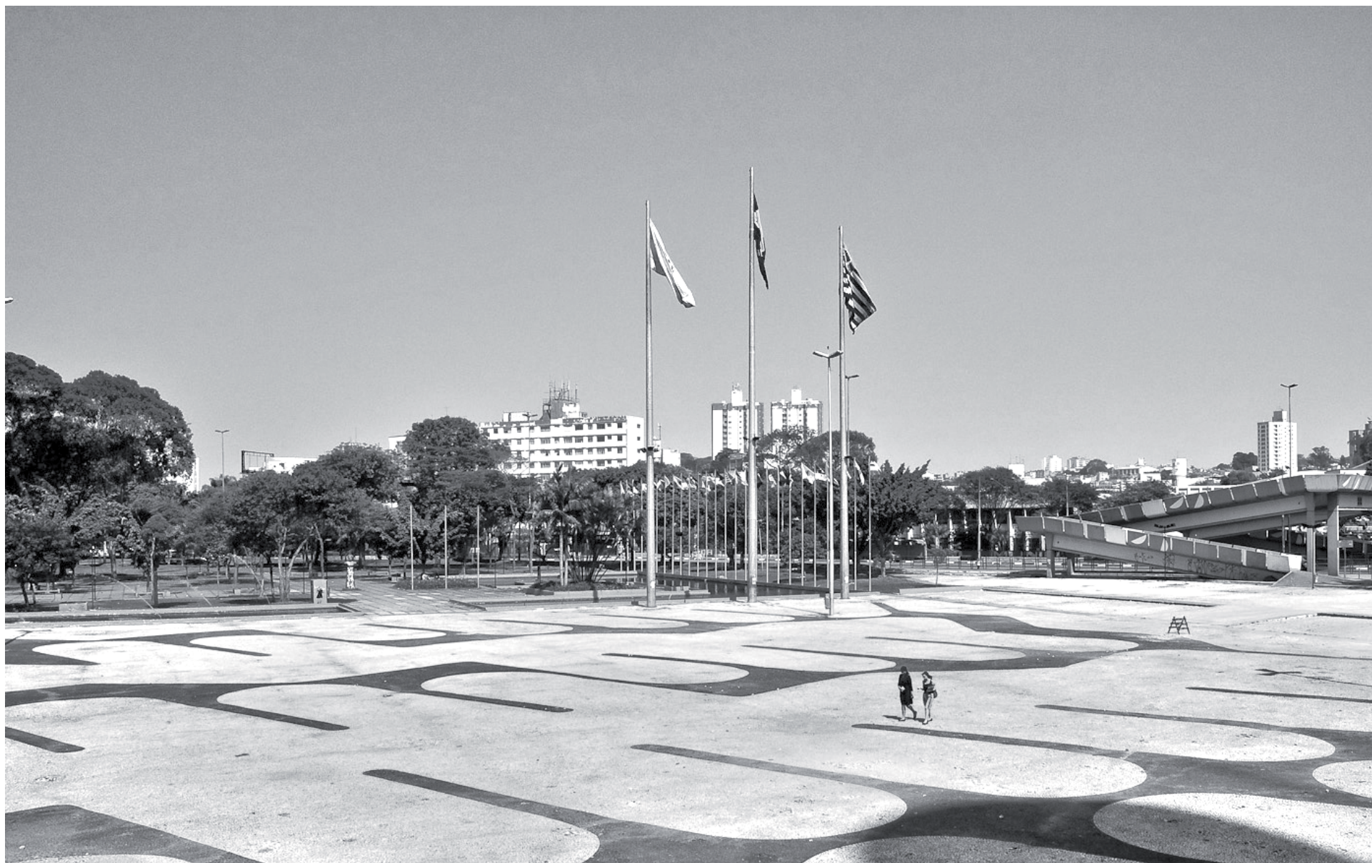
Paço Municipal de São Bernardo do Campo: vista da esplanada a partir da praça elevada. (BOSCARDIN, L. 2010)
