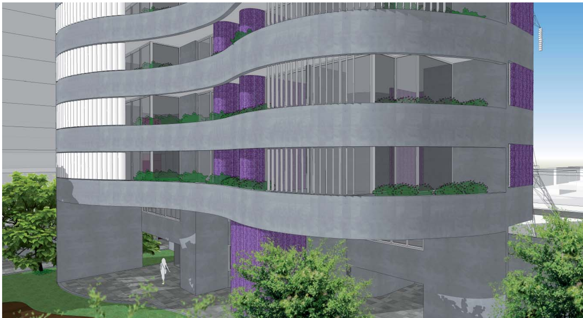
Edifício Gropius: destaque das vigas serpenteantes em concreto aparente que configuram terraços e floreiras. (BOSCARDIN, L. 2012)
