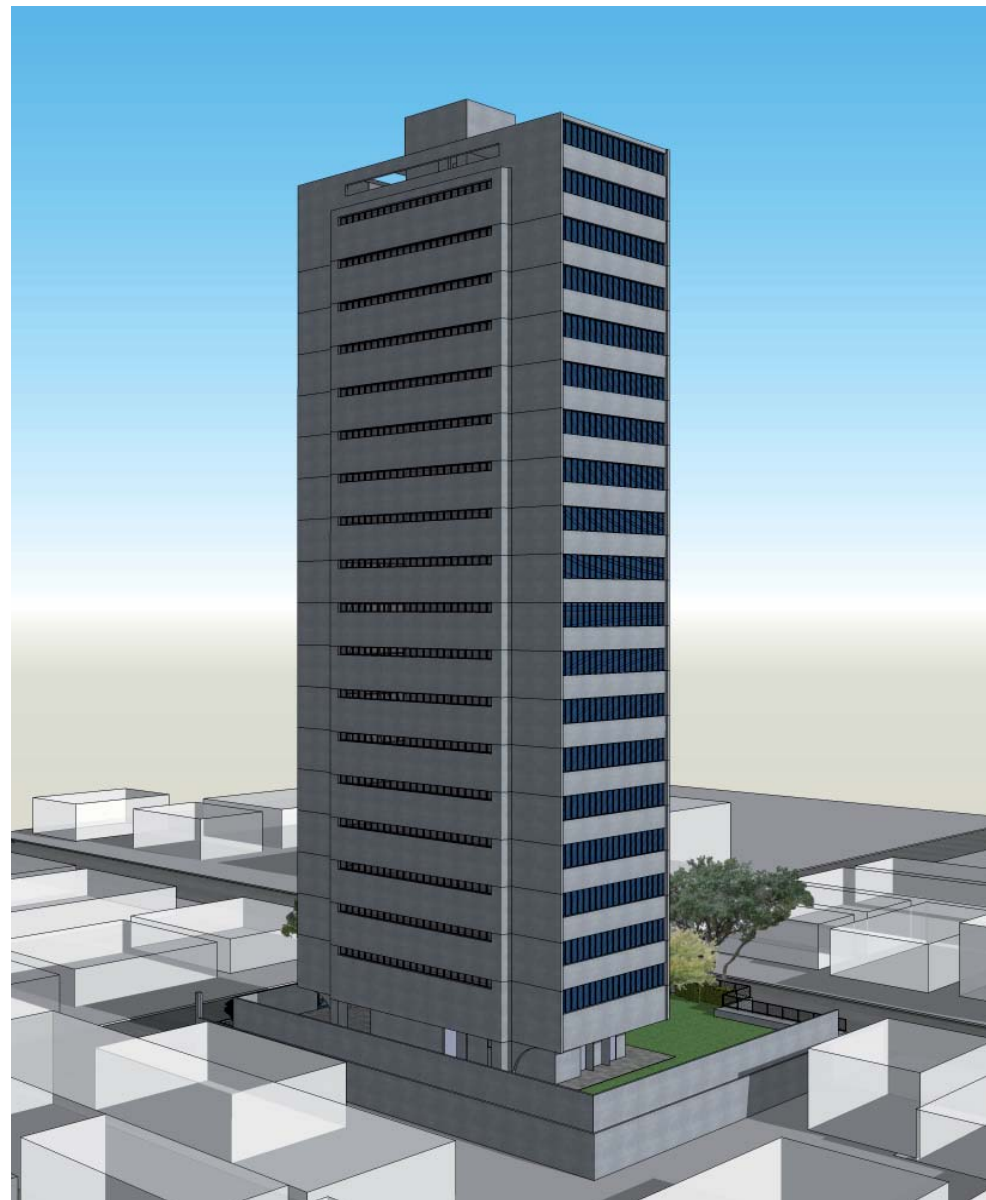
Edifício Village. Vista geral destacando as elevações sudeste e nordeste. (BOSCARDIN, L. 2011)
