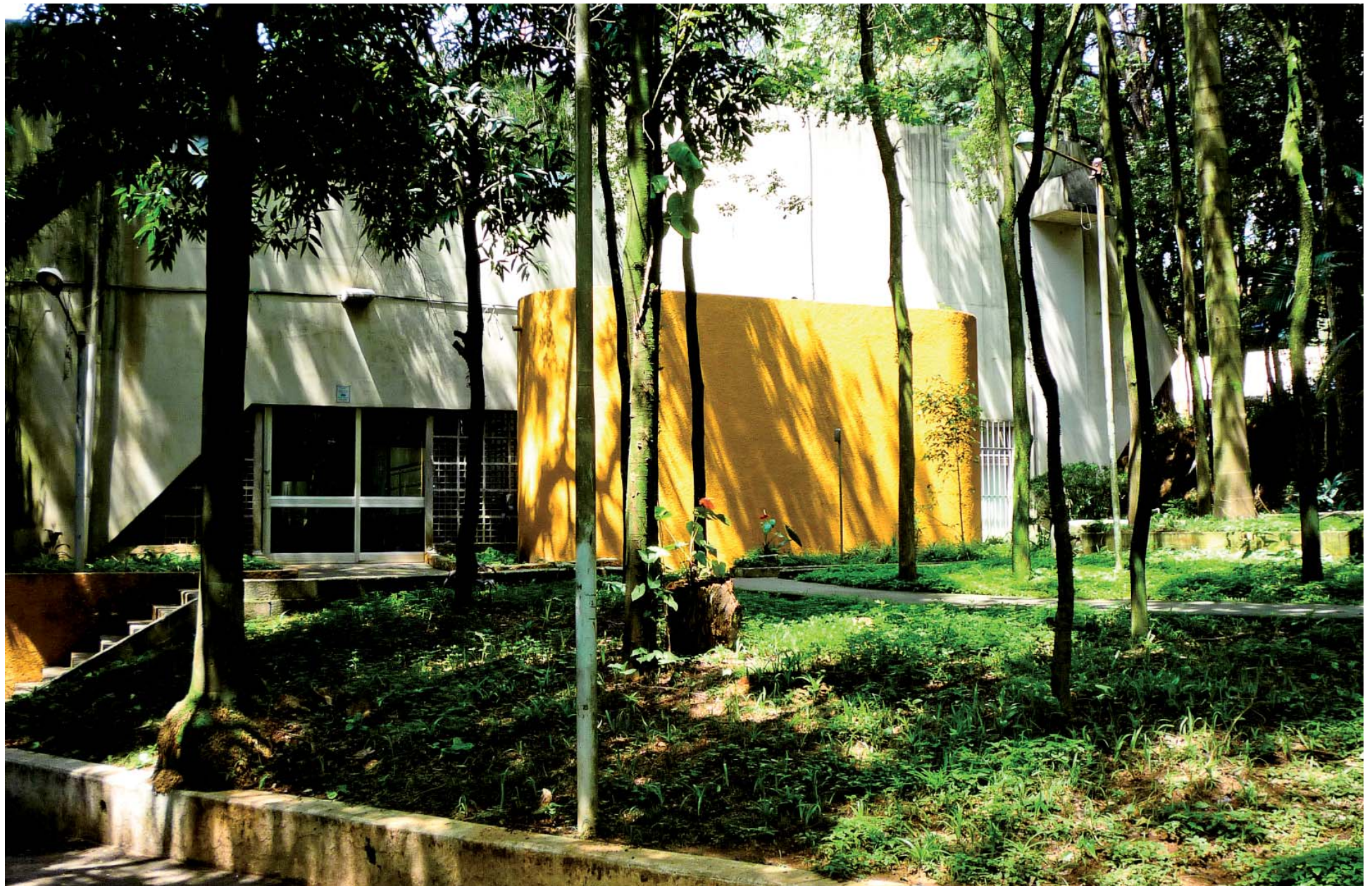
Edifício FAECO, em seu estado atual. (BOSCARDIN, L. 2012)
