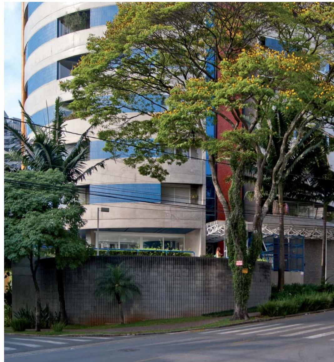
Edifício Gaudí: vista a partir da esquina da Rua das Pitangueiras x Rua das Paineiras, destacando o volume circular do terraço descoberto. (BOSCARDIN, L. 2012)
