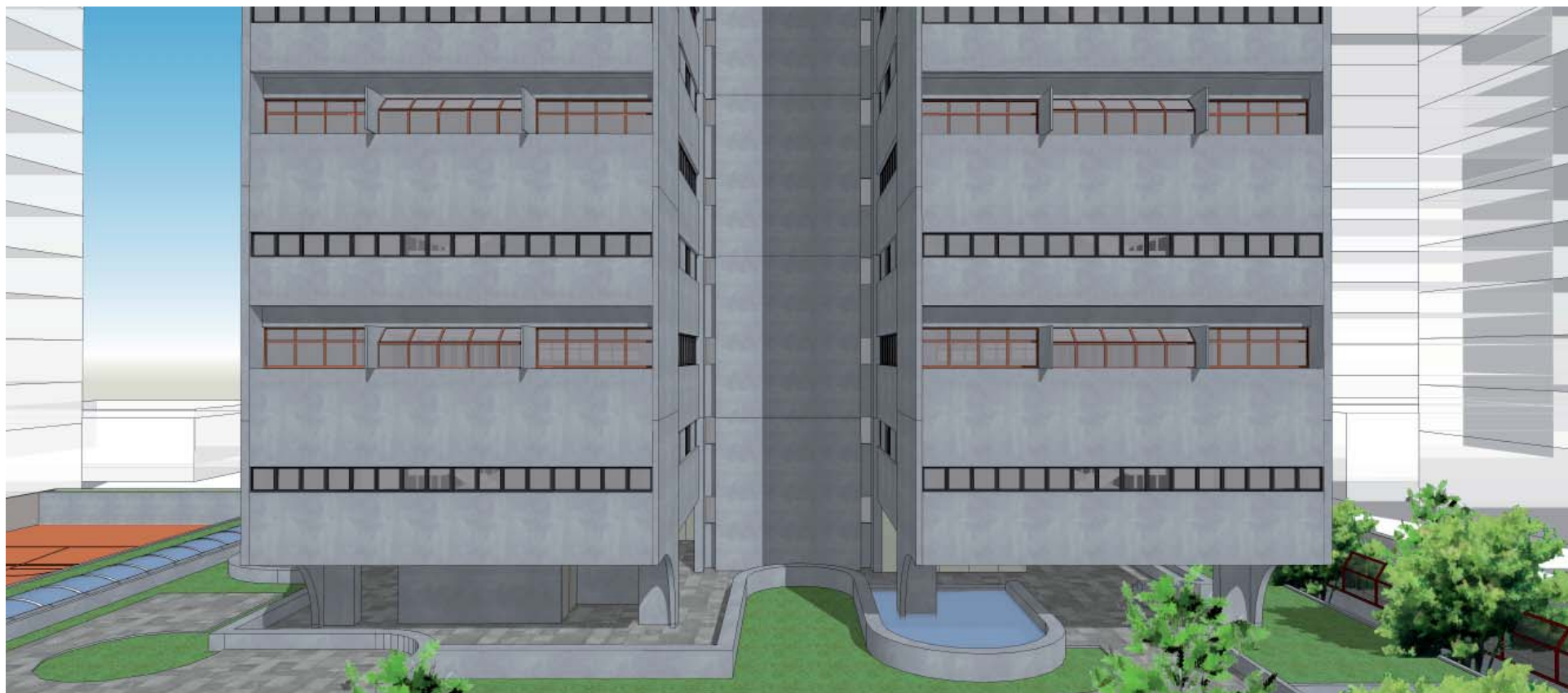
Edifício Kipos: vista da face noroeste, destacando a caixilharia do edifício. (BOSCARDIN, L. 2011)
