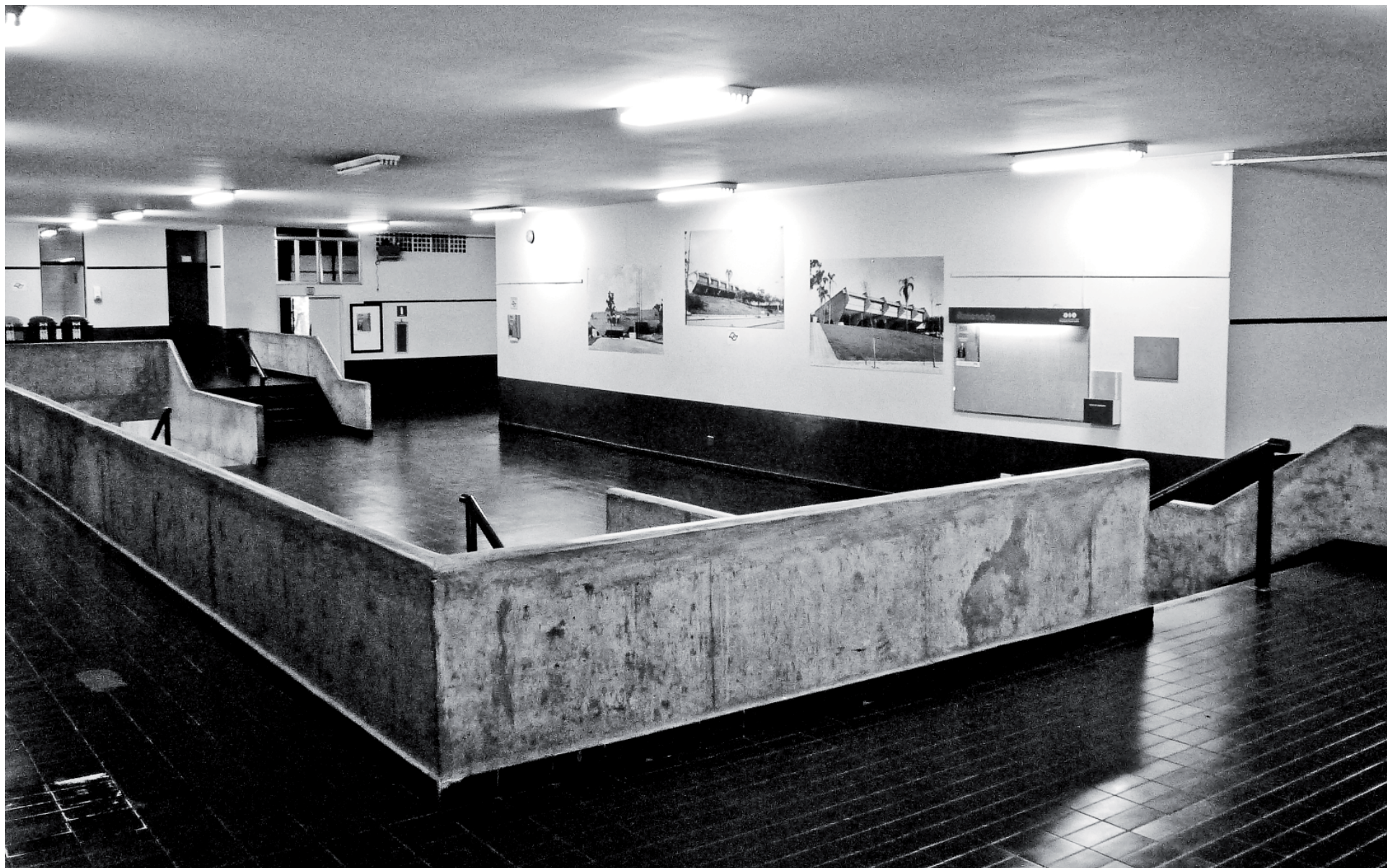
Edifício FAECO, em seu estado atual, destacando o saguão do pavimento superior. (BOSCARDIN, L. 2012)
