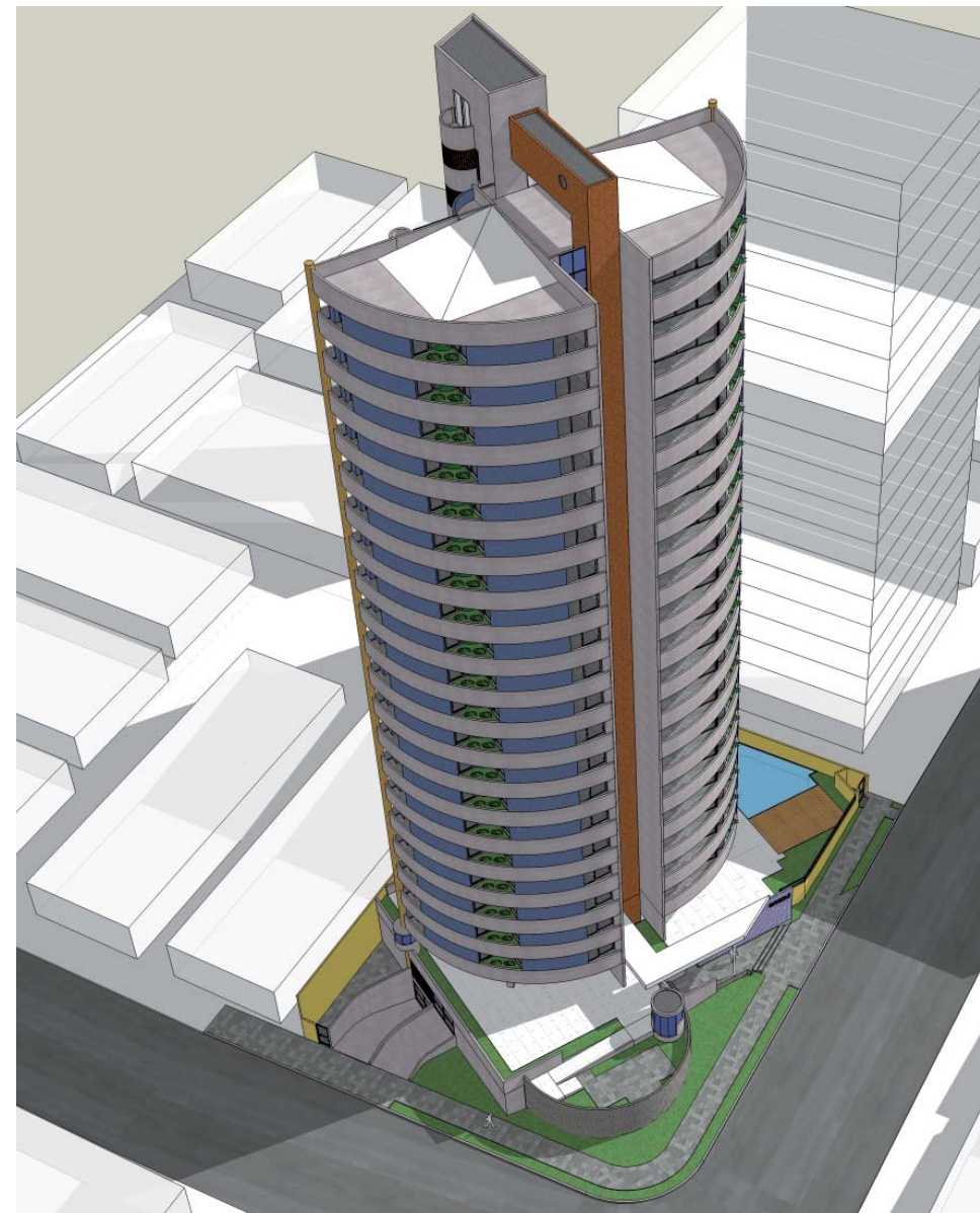
Edifício Gaudí: vista geral do edifício, destacando a face norte. (BOSCARDIN, L. 2012)
