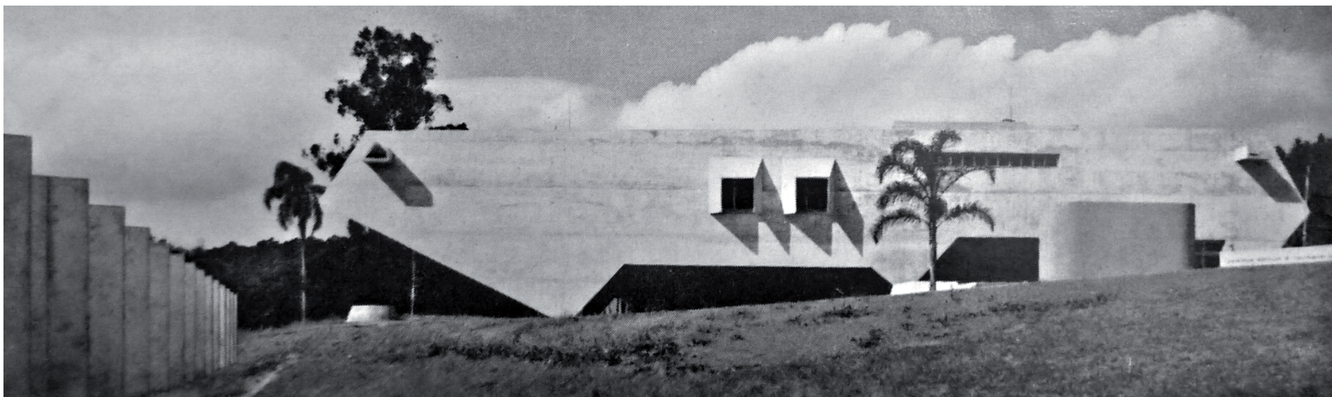
Edifício FAECO, na época de sua inauguração. Destaque da empena estrutural. (ACRÓPOLE, 355)
