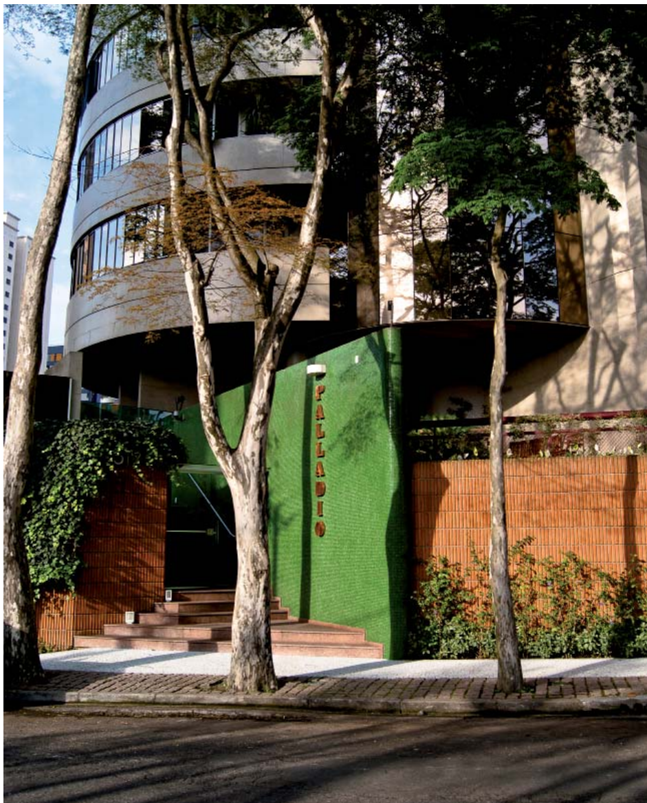
Edifício Palladio (2002): nesta imagem do embasamento, é possível observar a presença de elementos comuns aos edifícios residenciais projetados pelo escritório de Jorge Bomfim, como a configuração geral do acesso de pedestres; estrutura em concreto aparente, principalmente nas vigas de borda e em empenas estruturais; cortinas de vidro, brises soleil, e fechamentos em pastilhas cerâmicas ou tijolos. (BOSCARDIN, L. 2011)
