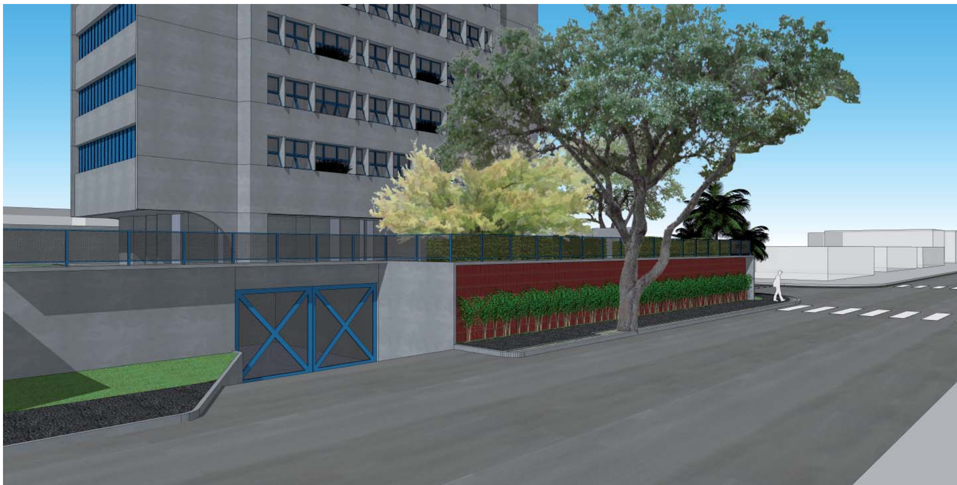
Edifício Village, destacando acesso de veículos ao subsolo pela Rua das Monções. (BOSCARDIN, L. 2011)
