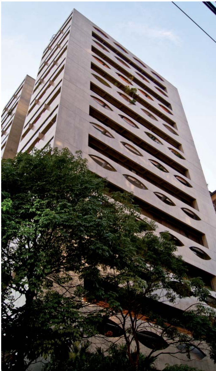
Edifício Kipos. (BOSCARDIN, L. 2011)
