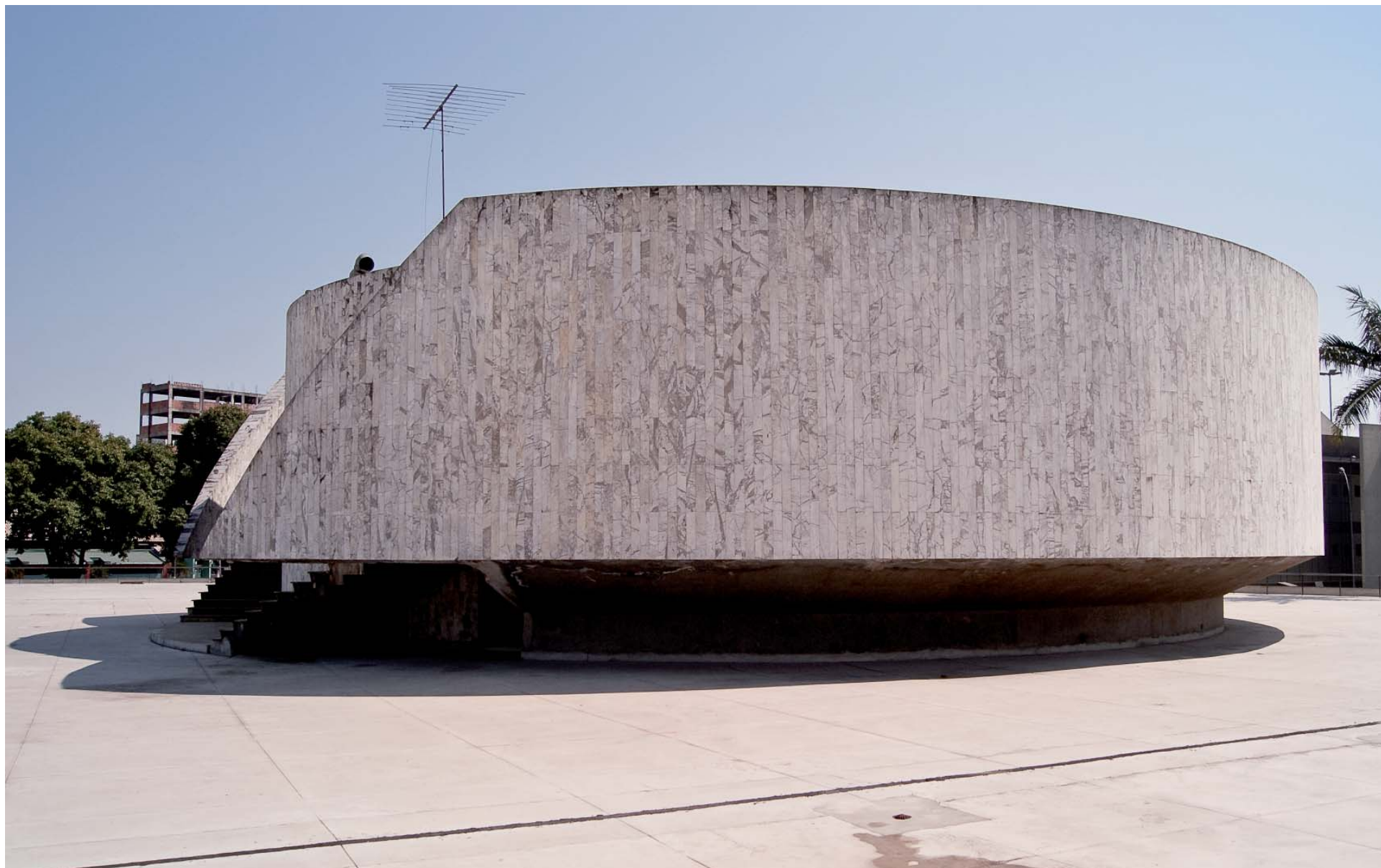
Paço Municipal de São Bernardo do Campo: vista da câmara dos vereadores, demolida em 2011. (BOSCARDIN, L. 2010)
