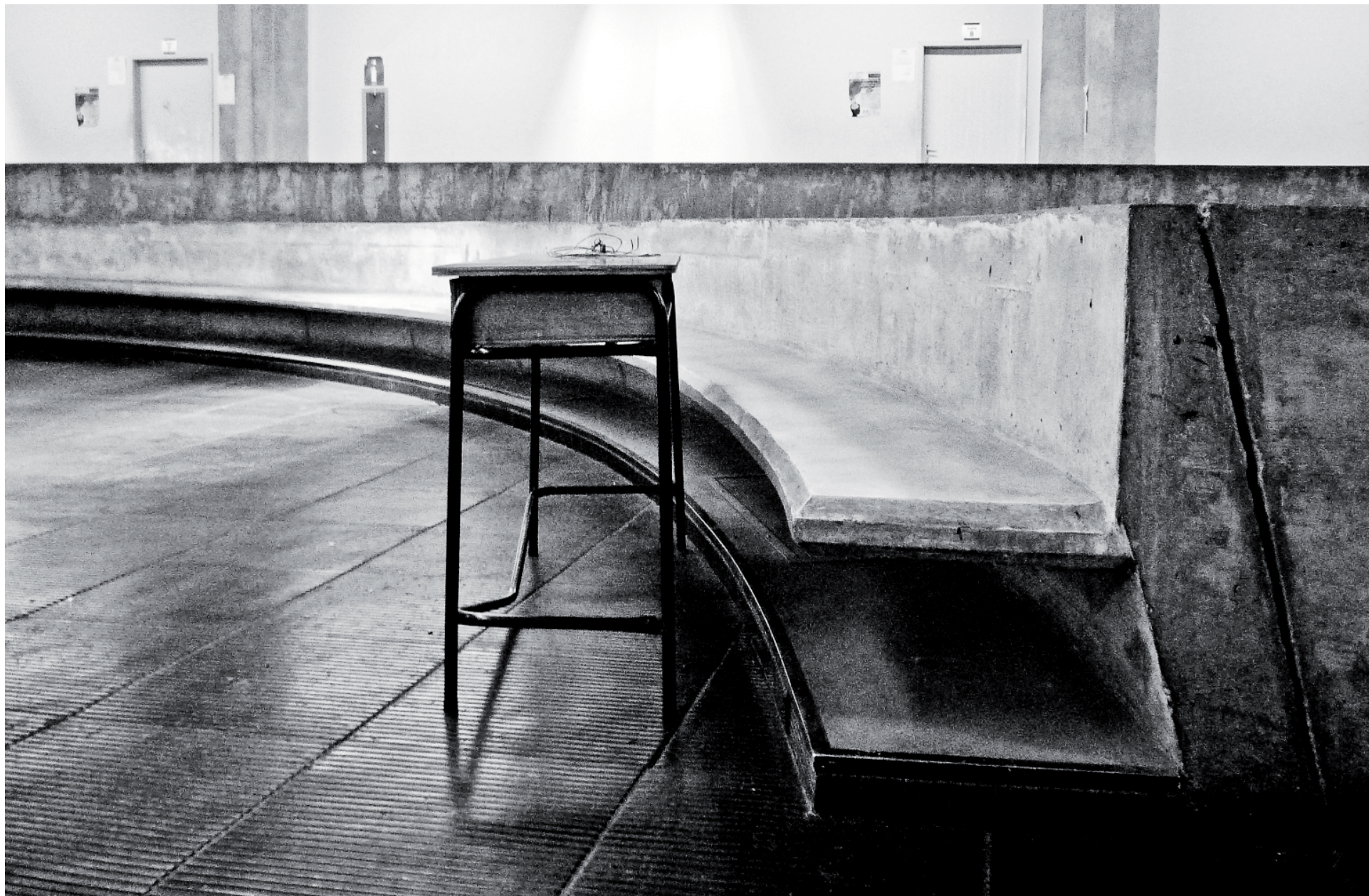
Edifício FAFIL, em seu estado atual. Destacando o detalhamento construtivo do edifício. (BOSCARDIN, L. 2012)
