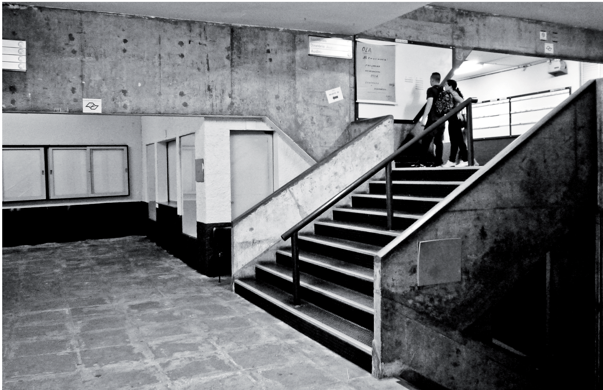
Edifício FAECO, em seu estado atual, destacando o hall de distribuição entre os três níveis que configuram o pavimento térreo.(BOSCARDIN, L. 2012)
