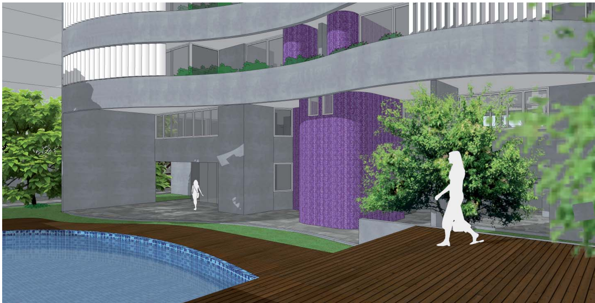
Edifício Gropius: vista do térreo, destacando pé-direito duplo do térreo, mezanino e empenas estruturais, com soluções semelhantes às utilizadas no edifício Octógono. (BOSCARDIN, L. 2012)
