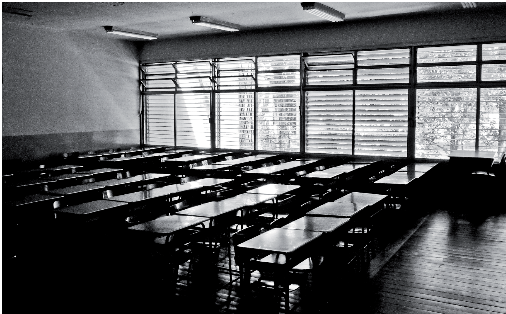
Edifício FAECO, em seu estado atual, destacando a preservada caixilharia e brises metálicos das salas de aula do pavimento superior. (BOSCARDIN, L. 2012)
