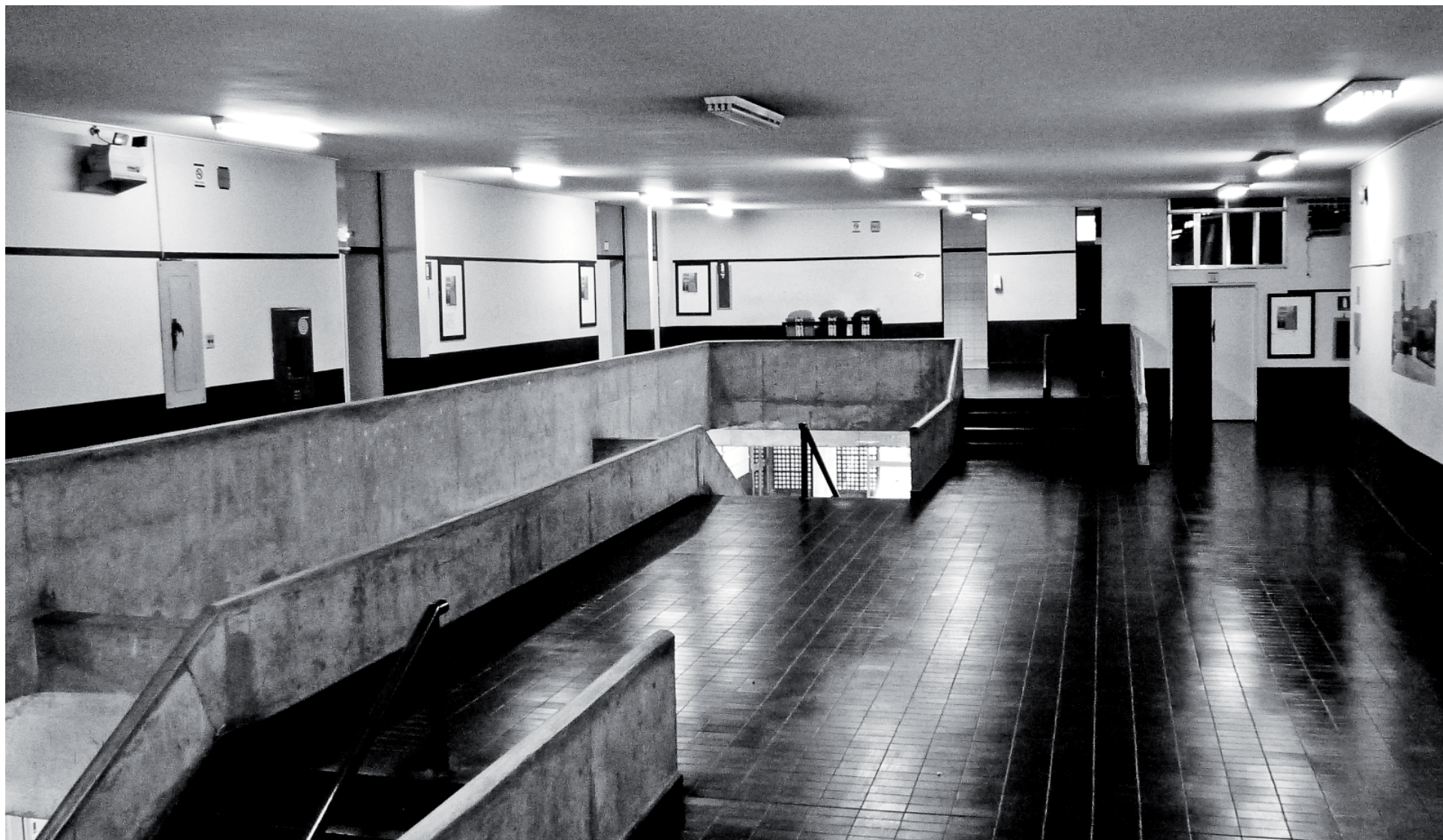
Edifício FAECO, em seu aspecto atual, destacando o saguão do pavimento superior. Notar o bom estado de conservação do edifício.(BOSCARDIN, L. 2012)
