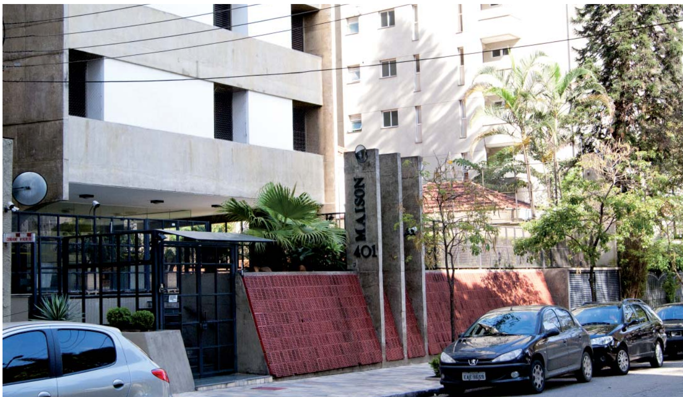
Edifício Maison, em seu aspecto atual. (BOSCARDIN, L. 2011)
