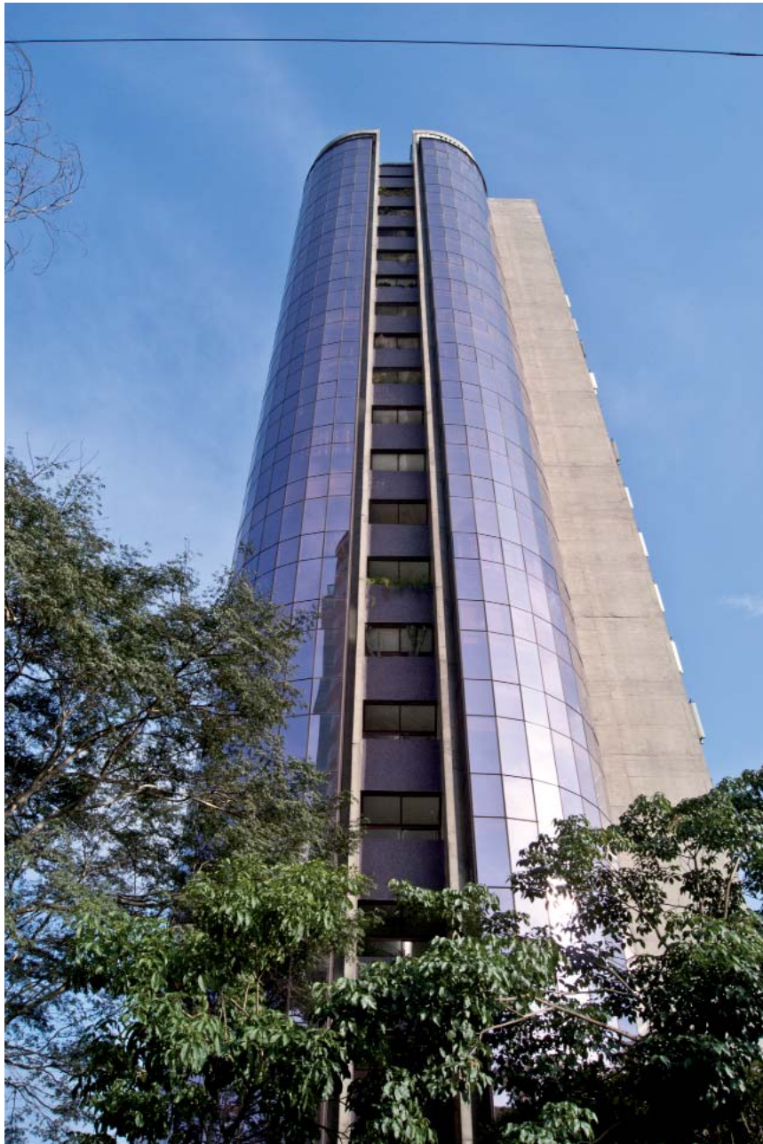
Edifício Gropius (BOSCARDIN, L. 2010)
