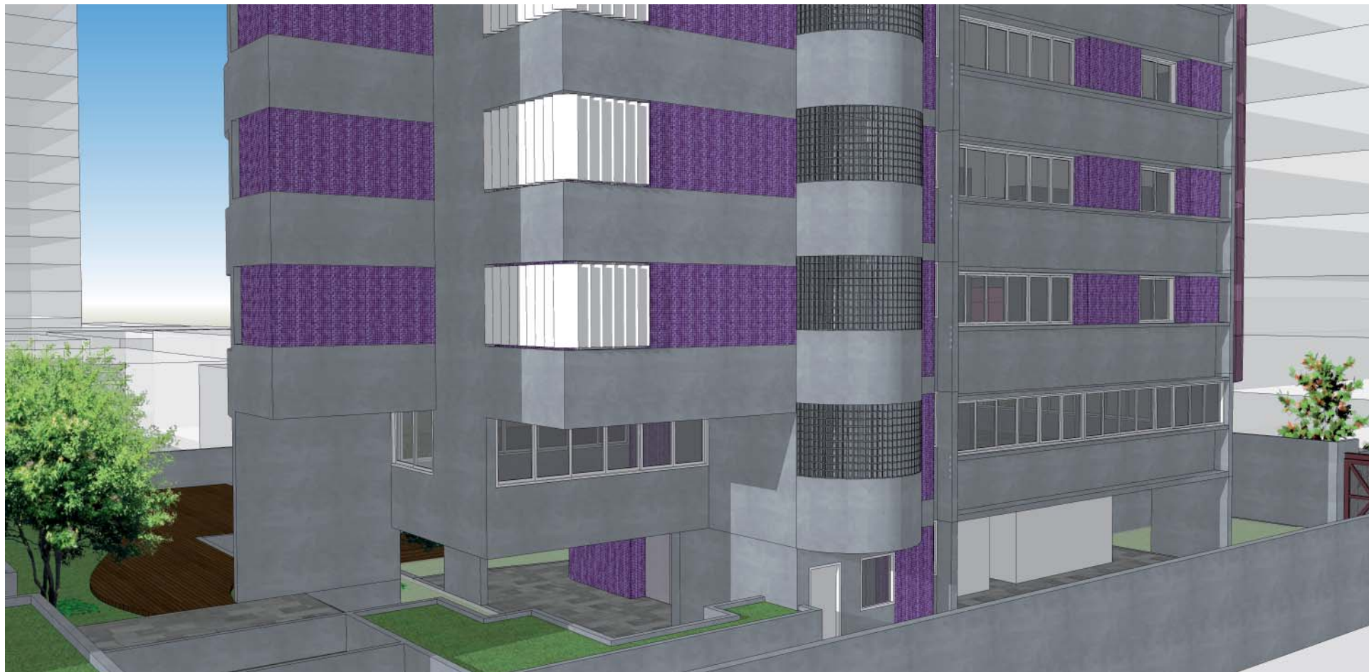
Edifício Gropius: face sudoeste, onde a volumetria é resultante da alternância de vigas de borda em concreto aparente e fechamentos revestidos com pastilhas cerâmicas vitrificadas. (BOSCARDIN, L. 2012)
