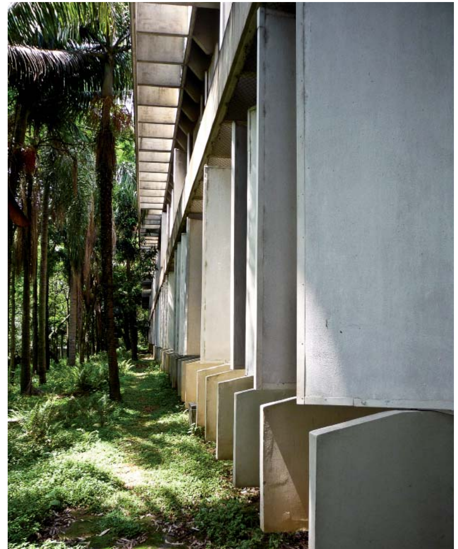
Edifício FAFIL, em seu estado atual, destacando a alteração realizada na década de 1980, com a adição de salas de aula no pavimento térreo. (BOSCARDIN, L. 2012)
