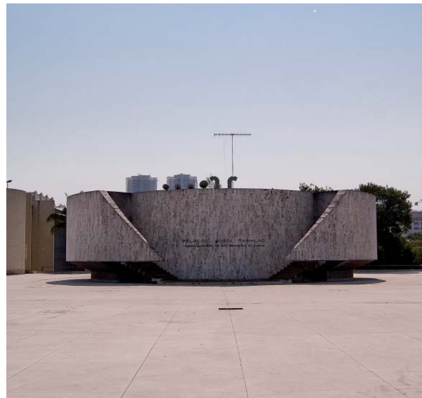
Paço Municipal de São Bernardo do Campo: vista da câmara dos vereadores, demolida em 2011. (BOSCARDIN, L. 2010)
