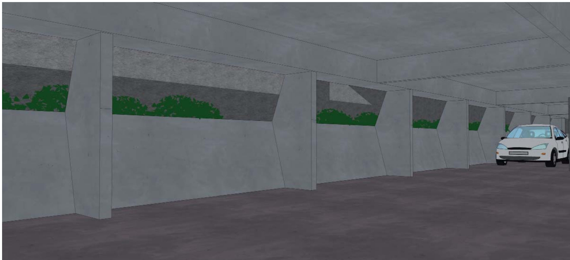
Edifício Mozart: vista interna do subsolo, destacando os rasgos de ventilação e o desenho dos pilares periféricos. (BOSCARDIN, L. 2011)
