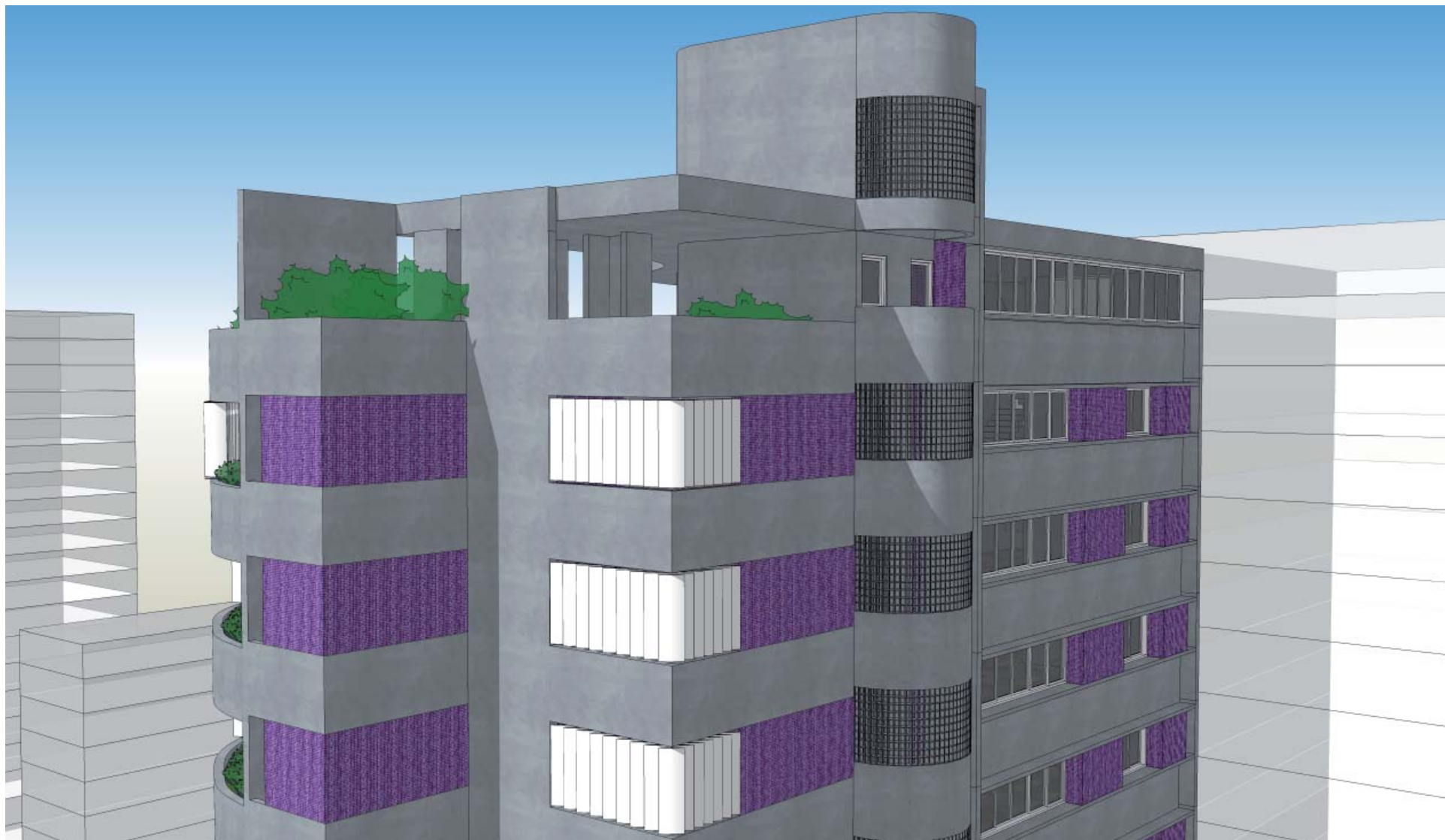
Edifício Gropius: parte superior da face sudoeste, destacando a alternância de vigas de borda em concreto aparente e fechamentos revestidos com pastilhas cerâmicas vitrificadas, e o uso de brises soleil nos terraços. (BOSCARDIN, L. 2012)
