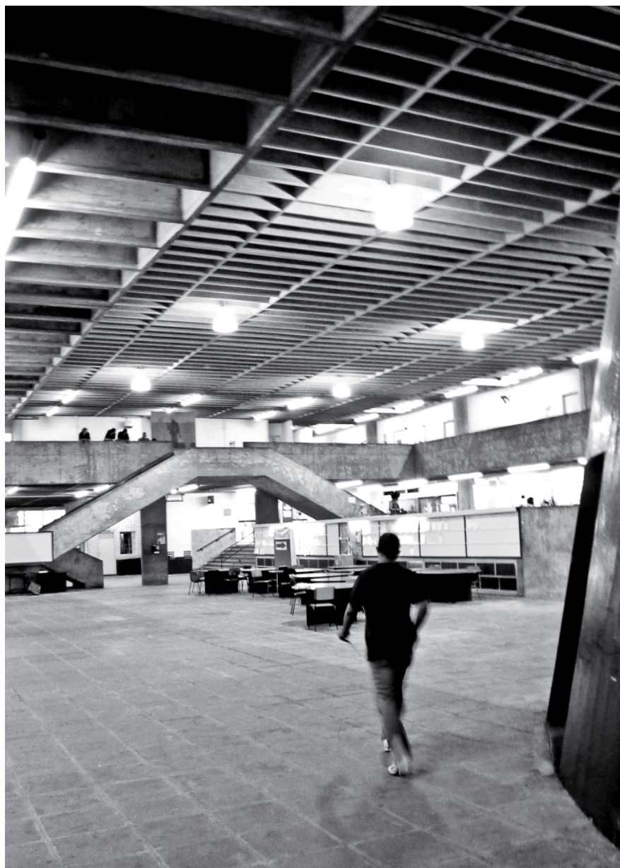
Edifício FAFIL, em seu estado atual, destacando o pavimento térreo e as escadas de acesso ao pavimento superior. (BOSCARDIN, L. 2012)
