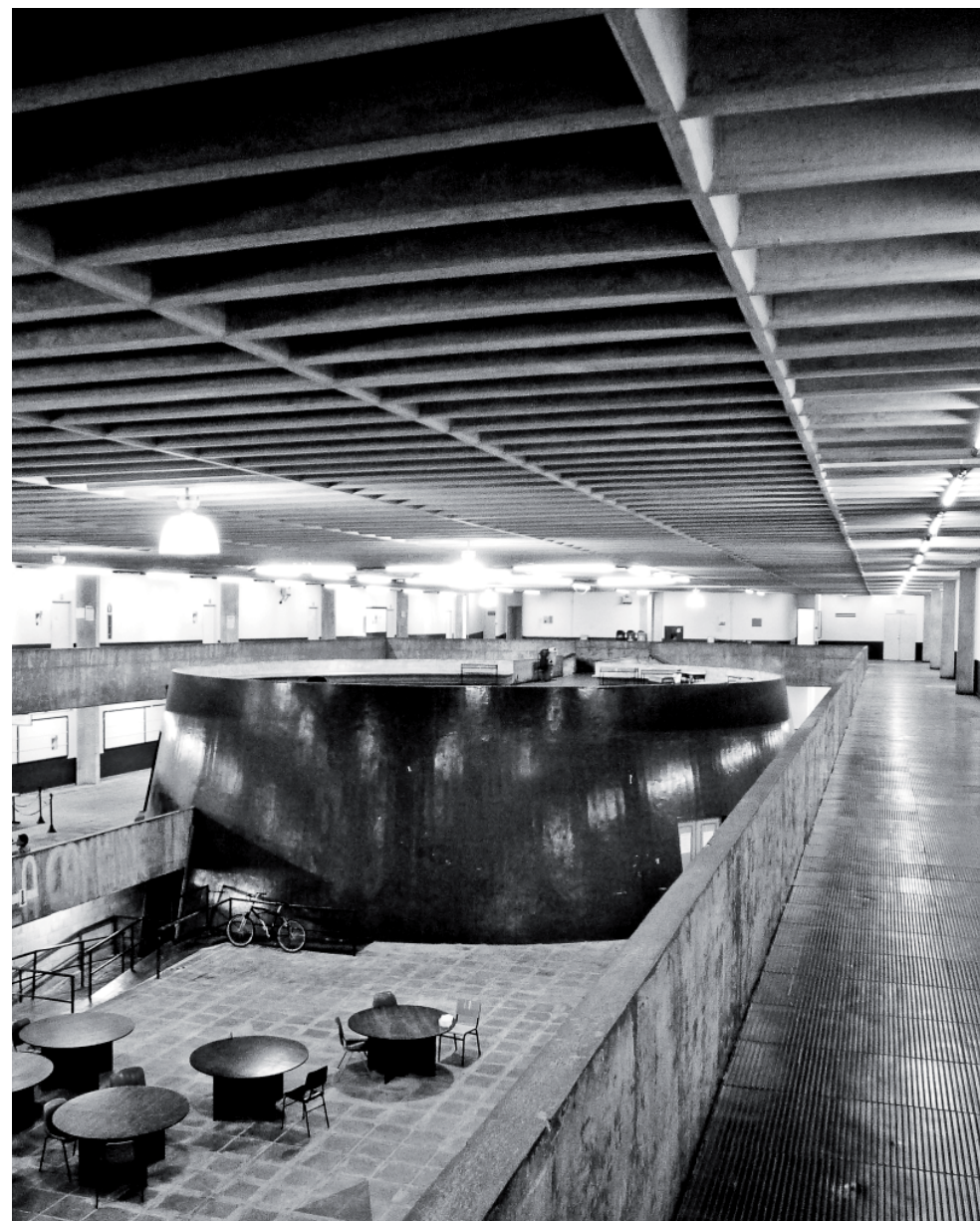
Edifício FAFIL, em seu aspecto atual, destacando a laje nervurada de cobertura e o auditório. Notar o bom estado de conservação do edifício. (BOSCARDIN, L. 2012)
