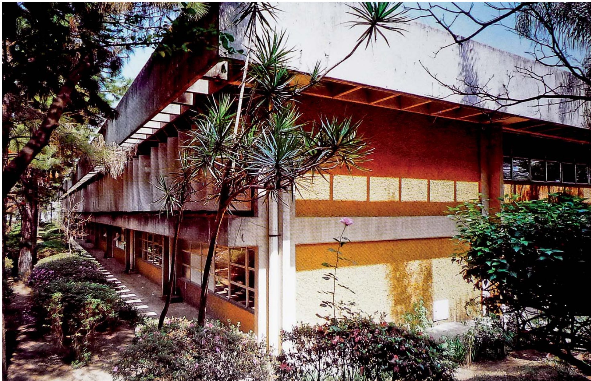
Edifício FAFIL, em seu estado atual, destacando as salas de aula no pavimento superior e salas de diretoria no pavimento térreo, localizadas na face oposta onde foram inseridas novas salas de aula. (BOMFIM, J. 1992)
