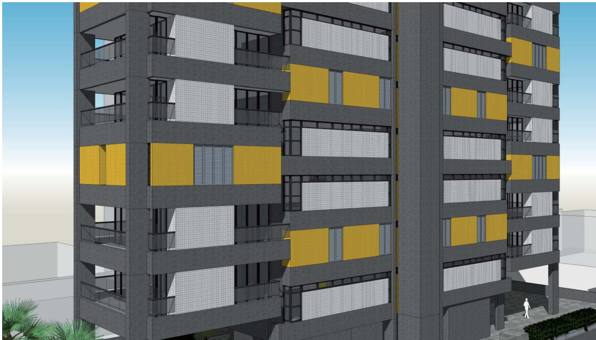
Edifício Mozart: elevação sudoeste, com destaque para as aberturas de terraços, aos variados tipos de caixilhos e composição entre elementos estruturais e de fechamento. (BOSCARDIN, L. 2011)
