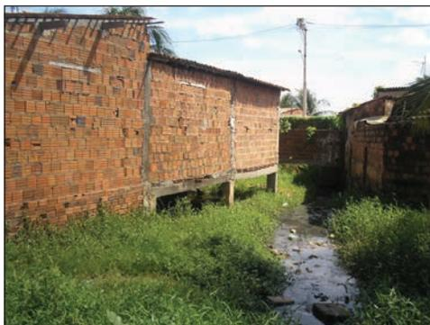
Figura 2.50 – Formas de adaptação das moradias ao risco de inundação na comunidade Genibaú II. O uso de aterros e palafitas é recorrente dada a ocupação de sítios inundáveis. *Fonte:* Foto do autor, maio de 2008.
